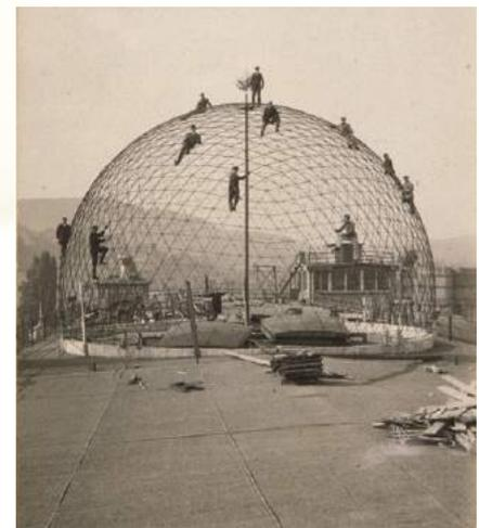
*Montage der Versuchskuppel auf dem Dach des Zeiss-Werks Jena im Jahr 1922. Die Schalenbauweise aus Beton wurde speziell für das Planetarium entwickelt.*
